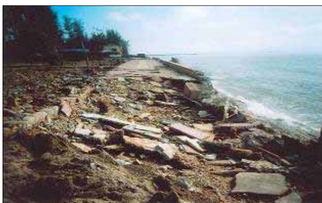
図10 暴風雨によって破壊されたドーソン町(ハイフォン省)のコンクリート製堤防
