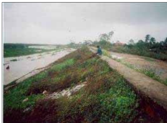
図11 マングローブのおかげで無傷で残った土の堤防
